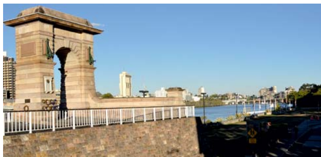
Ryc. 6. Zachowany łuk z pierwszego murowanego Mostu Wiktorii w Brisbane, zbudowanego z piaskowca Helidon. Filary i przęsła mostu zostały zbudowane z tufu brisbańskiego. Ryc. 3–6 fot. A. Kozłowska
