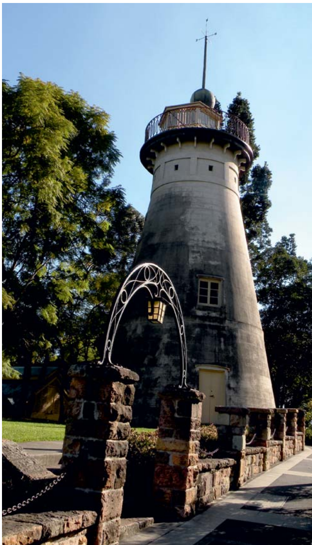
Ryc. 2. Stary Młyn – najstarszy zabytek w Brisbane wykonany z kamienia i cegły. Murek otaczający budowlę został zbudowany z tufu brisbańskiego. Fot. K. Jarmolowicz-Szulc
