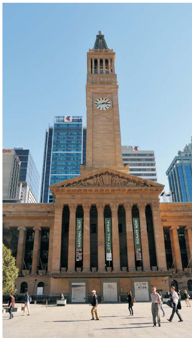
Ryc. 7. Budynek Ratusza Miejskiego, którego ściany zostały obłożone piaskowcem Helidon. Fot. A. Kozłowska
