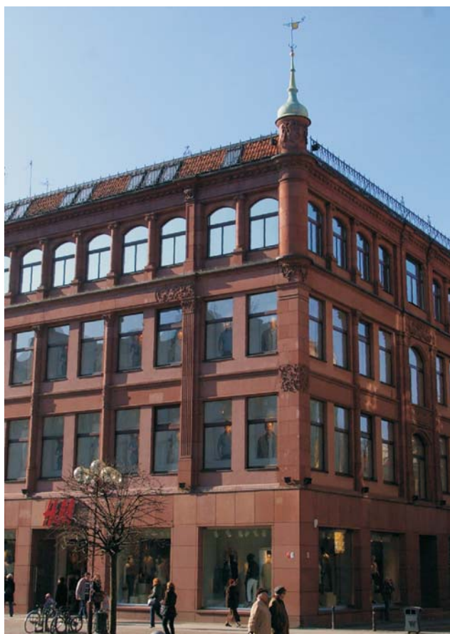
Ryc. 1. Czerwony piaskowiec noworudzki na fasadzie domu handlowego – dawnego Geschäftshaus Schottländer (ul. Świdnicka). Fot. K. Zagożdżon
