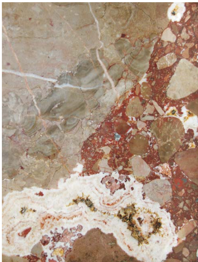
Ryc. 6. „Marmur” (zlepieniec) zyguntowski na posadzce budynku C-7 Politechniki Wrocławskiej (długość pola widzenia ok. 45 cm). Fot. P. Zagożdżon
