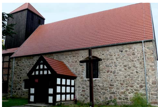
Ryc. 6. Kościół w Dominikowie zbudowany z nieobrobionych głazów narzutowych. Fot. M. Górska-Zabielska, 2012 r.
