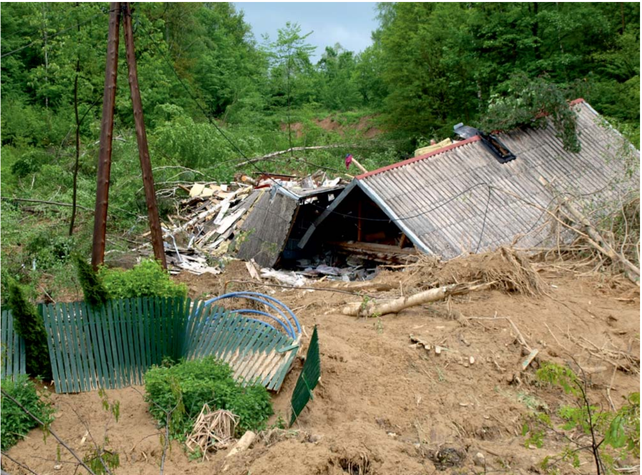
Ryc. 2. Widok na zniszczony przez osuwisko budynek mieszkalny w Nowym Sączu w 2010 r. Fig. 2. View of the landslide that destroyed a residential building in Nowy Sącz in 2010
