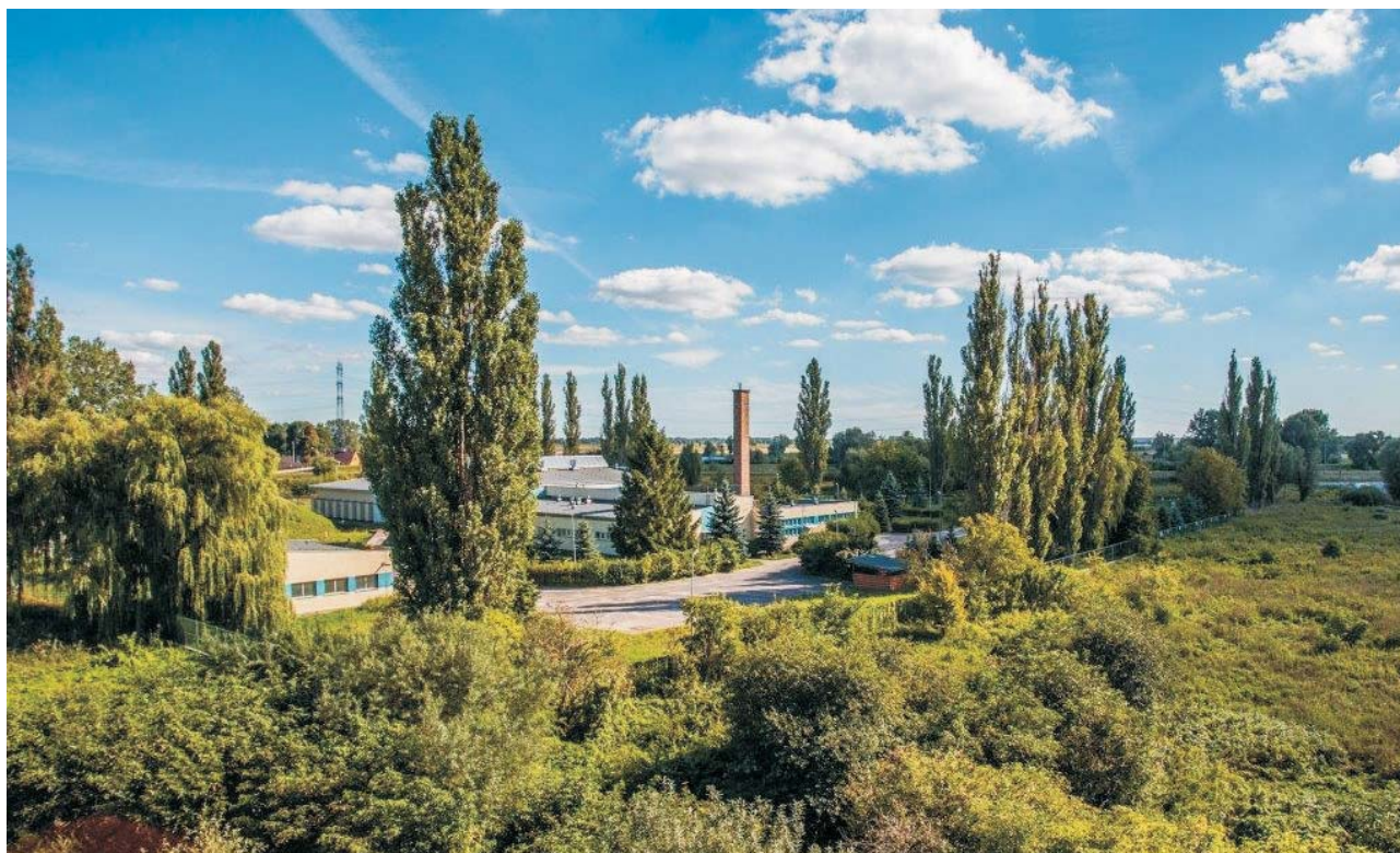
Ujęcie wody podziemnej „Lipce” w Gdańsku – stacja uzdatniania wody. Fot. z arch. GIWK Sp. z o.o.
