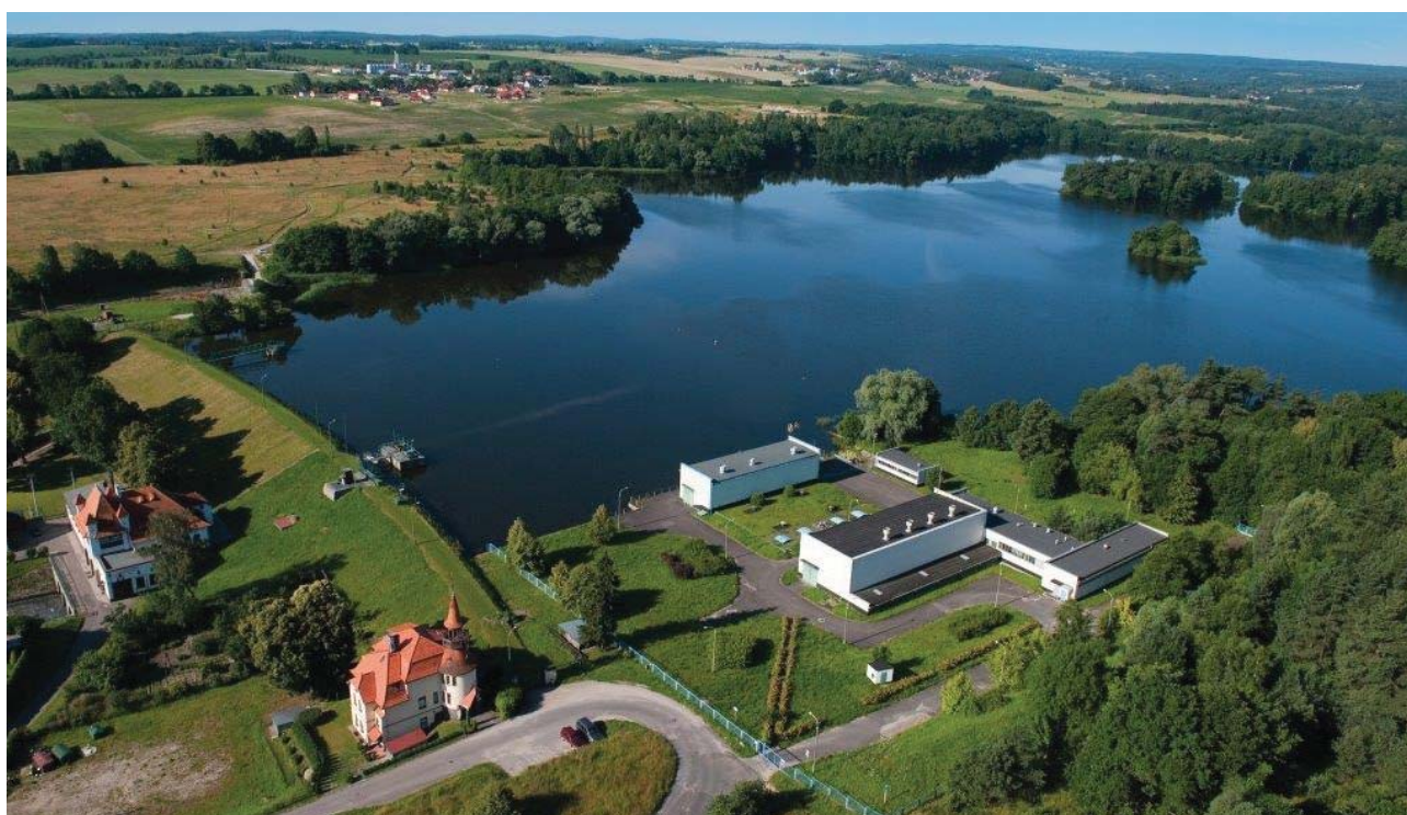
Stacja uzdatniania wody na ujęciu powierzchniowym „Straszyn”. Fot. z arch. GIWK Sp. z o.o.
