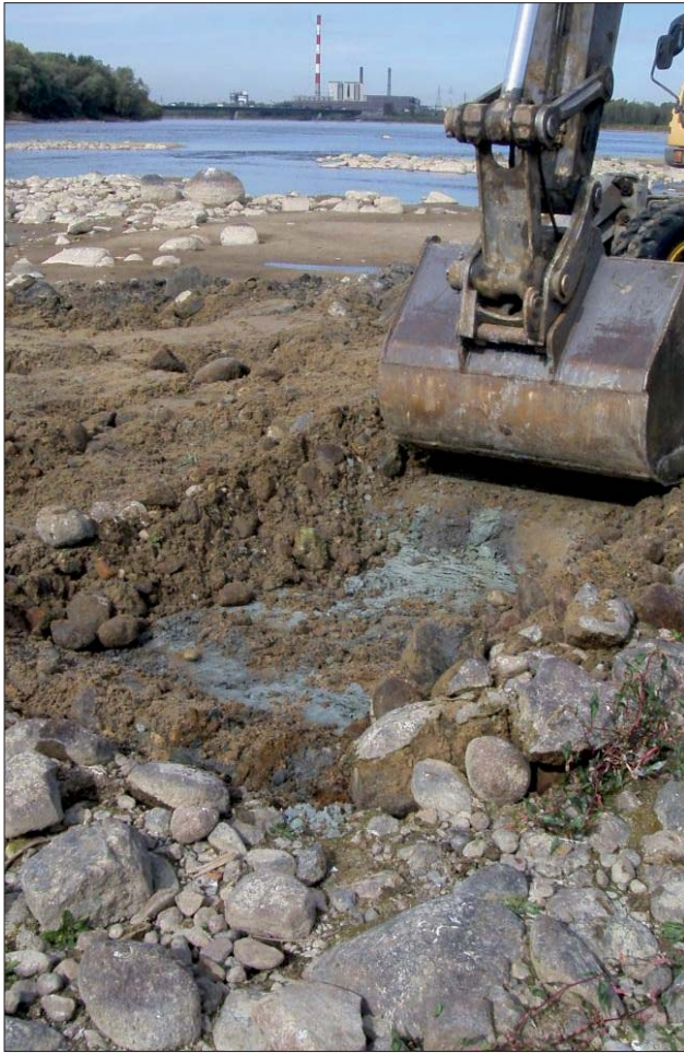
Ryc. 1. Układ warstw gruntowych w proggu („rafa”) występującej w dnie rzeki Wisły. Zdjęcie wykonane w okresie niżówkowym. Fot. P. Kuźniar
