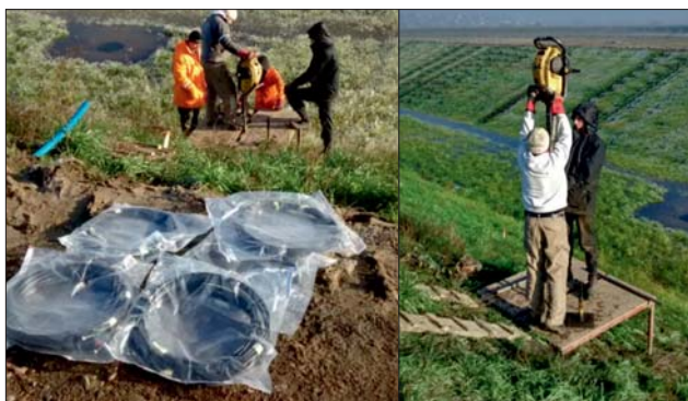
Ryc. 6. Montaż testowych czujników temperatury Fig. 6. Installation of testing temperature sensor
