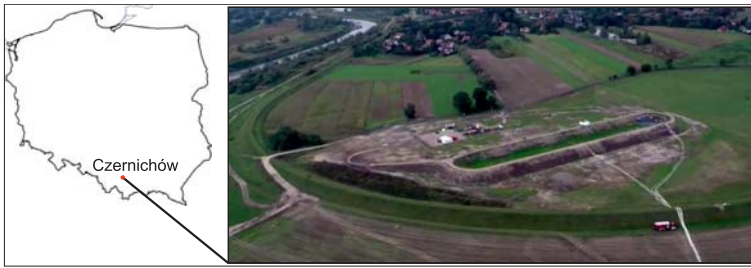
Ryc. 1. Lokalizacja eksperymentalnego wału przeciwpowodziowego w Czernichowie ( http://tvn24.pl )
