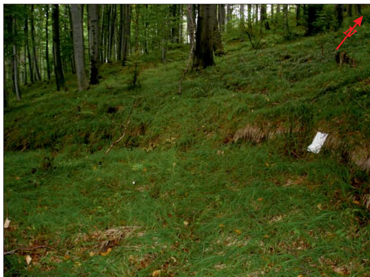
Ryc. 5. Skarpa główna północnej części osuwiska – rok 2014. Fot. J. Kos Fig. 5. Main scarp of the landslide's northern part – 2014 year. Photo by J. Kos
