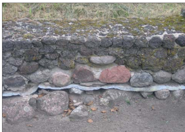
Ryc. 6. Ostrów Lednicki. Fragment podmurówki kościoła grodowego zbudowany z darniowej rudy żelaza
