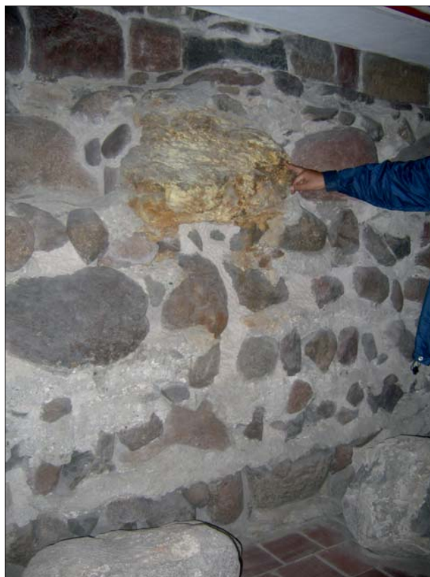
Ryc. 2. Gniezno. Przykład murów zbudowanych z głazów narzutowych z fragmentem martwicy wapiennej, oddzielających nawę główną od nawy bocznej w trójnawowej katedrze (XI w.). Wszystkie fot. J. Skoczylas
