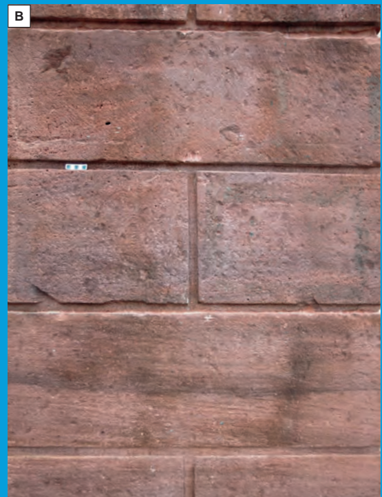
Ryc. 26. A – brama w południowej części muru zewnętrznego, wykonana z piaskowców suchedniowskich lub wąchockich w 1901 r.; B – przekątne i poziome warstwowania oraz drobne pustki po intraklastach ilu widoczne w piaskowcu o genezie rzecznej. Wszystkie fot. Z. Złonkiewicz Fig. 26. A – gate in the southern part of the external wall made of Suchedniów sandstones or Wąchock sandstones in 1901; B – cross and horizontal bedding, small voids of clay intraclasts in an alluvial sandstone. All photos by Z. Złonkiewicz
