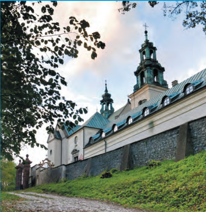
Ryc. 3. Kościół i klasztor – widok od południa. Mur zewnętrzny oraz brukowana droga wykonane z lokalnych wapieni środkowego–górnego dewonu Fig. 3. The church and cloister – view from the south. External walls and cobbled road made of local Middle–Upper Devonian limestones
