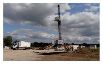
Fig. 7. Re-abandonment of the H-RIM70 well using the DIR 5505 drilling rig, Staré Pole near Nesyt (Propagační materiál PKÚ, 2014)
