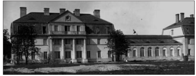
Ryc. 7. Zachodnia część pawilonu południowego tuż po ukończeniu budowy w 1926 r. Nar. Arch. Geol. PIG-PIB Fig. 7. Western part of the southern pavilion just after completion of construction in 1926. NGA, PGI-NRI
