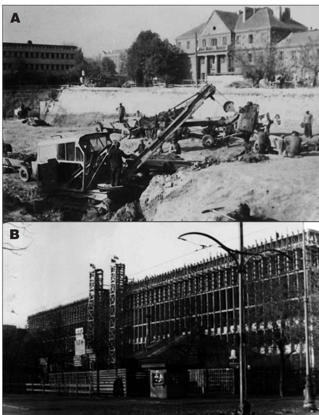
Ryc. 16. Budowa gmachu PIG przy ul. Rakowieckiej 4. A – początek, B – blisko końca (zdjęcie zamieszczone w tygodniku Stolica z dn. 28.11.1951 r.). Arch. PIG-PIB
