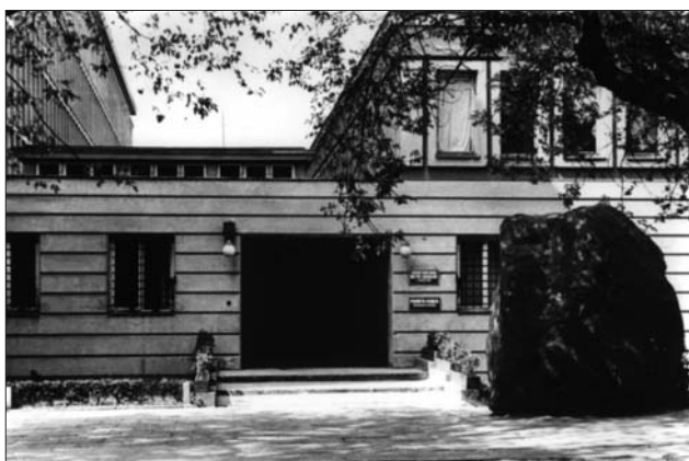
Ryc. 19. Wejście do instytutu – widoczne trzy części budynku (biurowa po lewej i laboratoryjna po prawej); 1960 r. Arch. PIG-PIB
