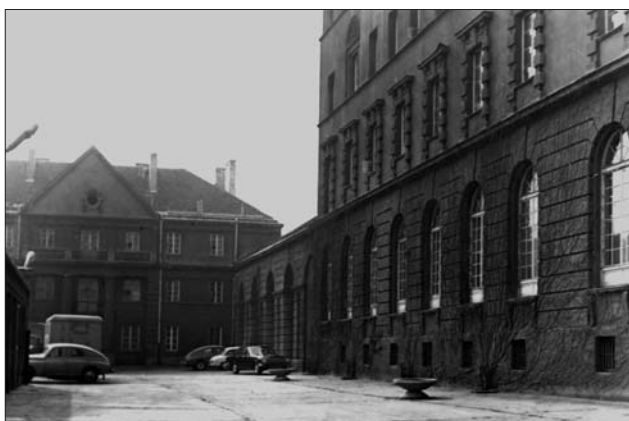
Ryc. 15. Wschodnia fasada PIG po odbudowie, widok z 1960 r. (po lewej stronie garaże – samowola budowlana z pierwszych lat powojennych, usunięta w latach 90.). Arch. PIG-PIB
