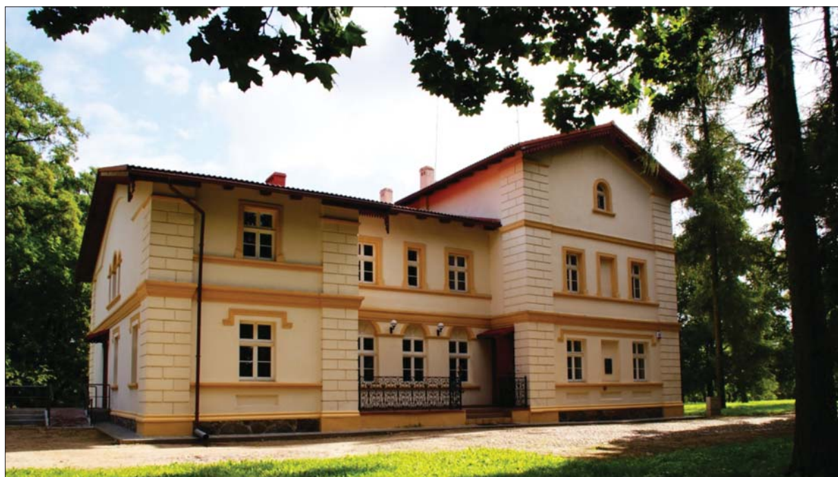
Ryc. 2. Dworek w Leszczach po kapitalnym remoncie w 2010 r. Fot. A. Dąbrowska
