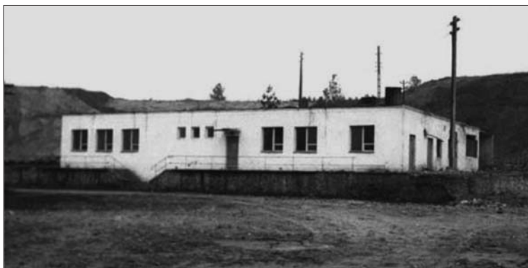
Ryc. 3. Budynek administracyjno-socjalny w Kielnikach w chwili przejścia w 1978 r. Archiwum Fot. Geologicznej NAG
