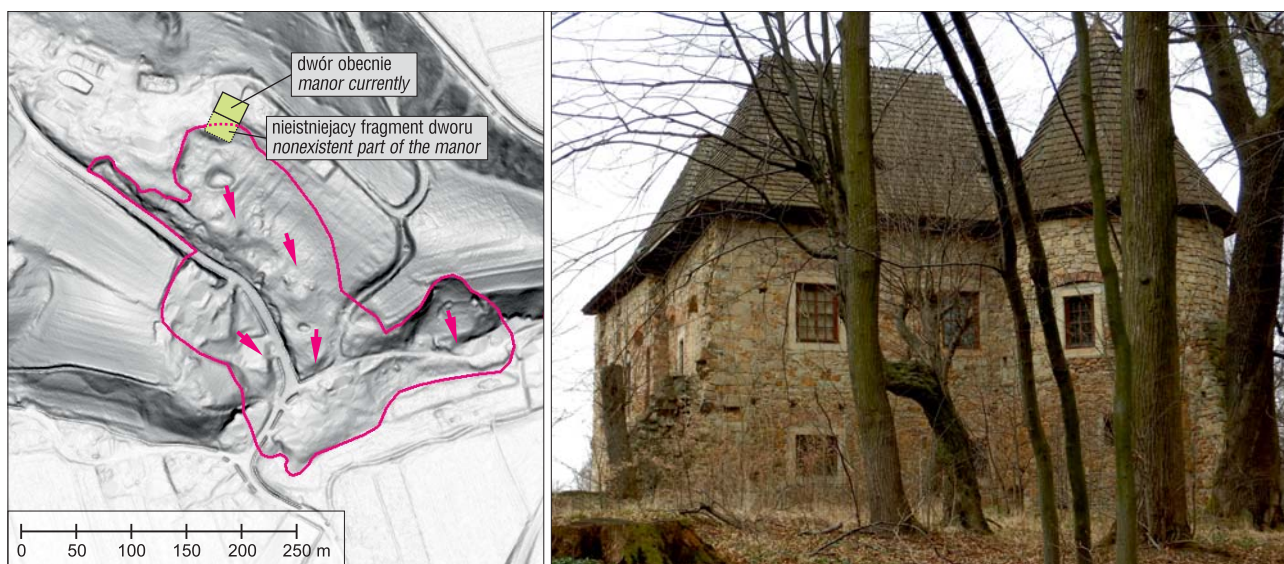
Ryc. 2. Osuwisko i dwór w Wieruszycach Fig. 2. Landslide and manor in Wieruszycach
