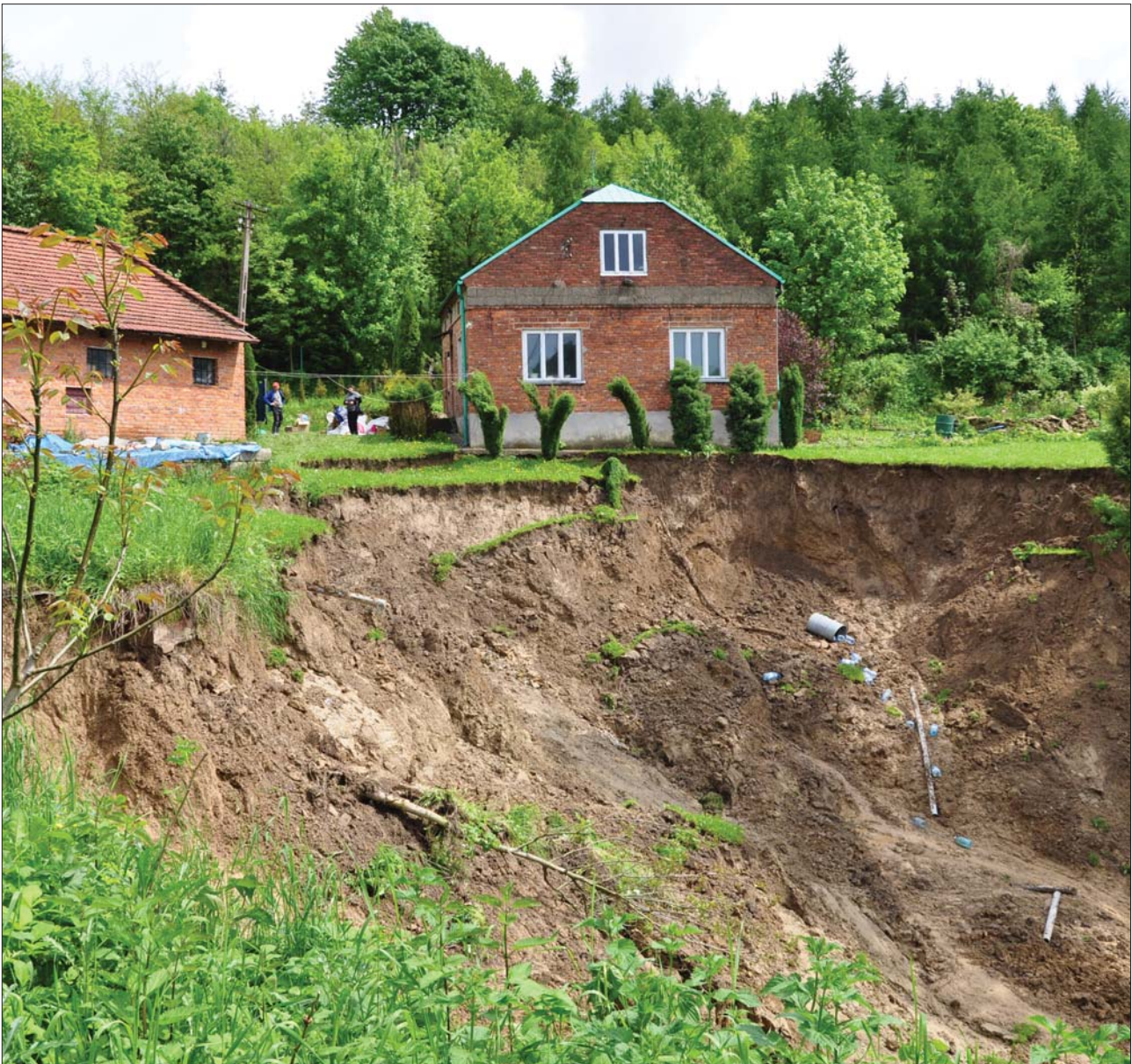
Budynki bezpośrednio zagrożone przez skarpe główną aktywnego osuwiska w miejscowości Dylągowa (gmina Dynów, powiat rzeszowski). Arch. PIG-PIB
