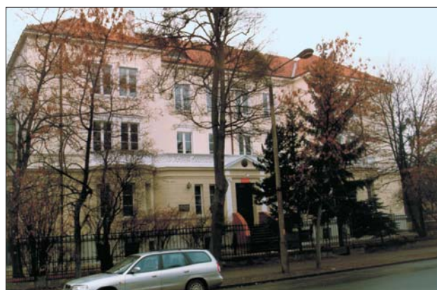
Ryc. 1. Budynek Oddziału Dolnośląskiego PIG-PIB
