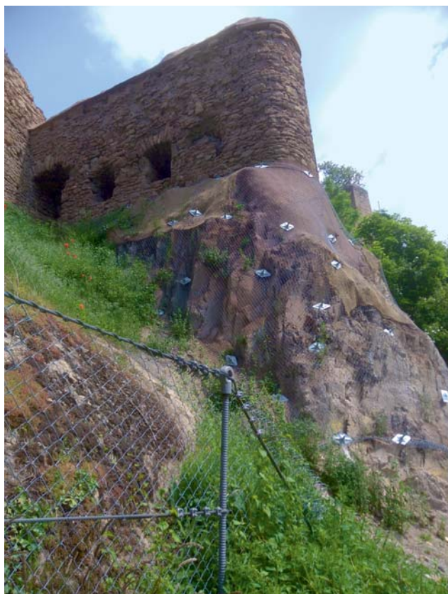
Ryc. 3. Stabilizacja potencjalnych obrywów skalnych na obszarze zamku Ehrenburg za pomocą systemu złożonego z barier ochronnych oraz mat erozyjnych i stalowych siatek drucianych kotwionych poprzez gwoździowanie i płytki kotwiące
