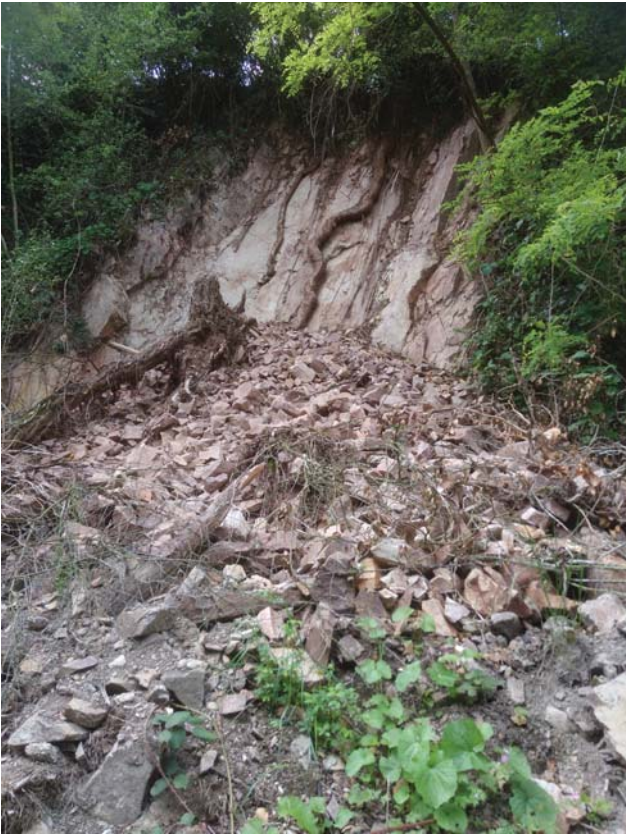
Ryc. 5. Niewielkie aktywne osuwisko konsekwentne w rejonie zamku Ehrenburg, które powstało po mechanicznym usunięciu rumowiska u podnóża skarpy
