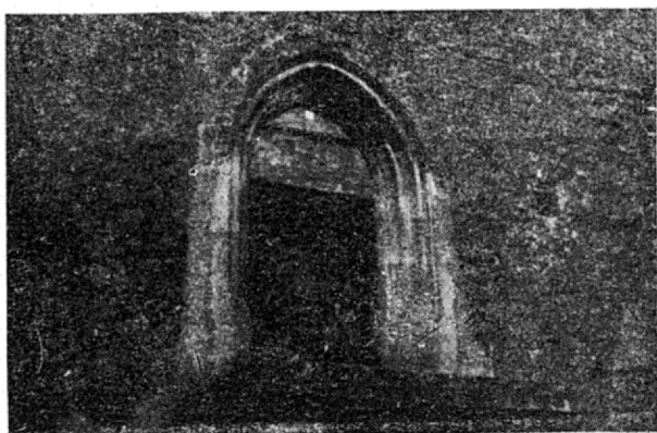
Szydłów. Zamek, portal parteru. (Fot. F. Kanclerz)
