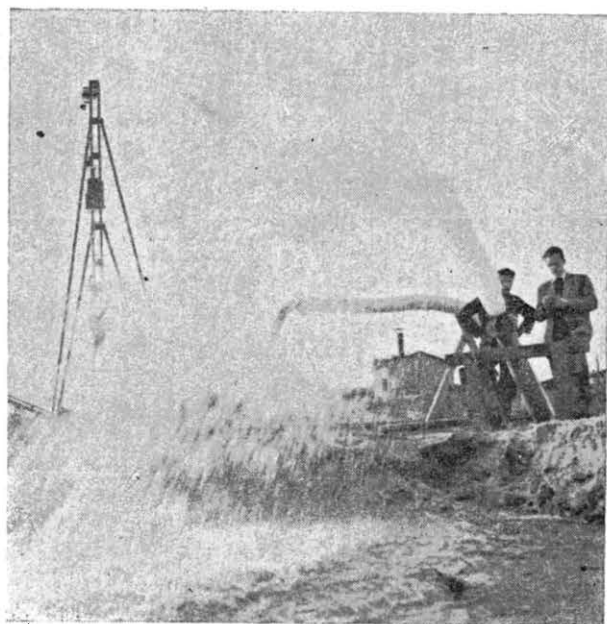
Próba nowego wodociągu (Fot. CAF)
