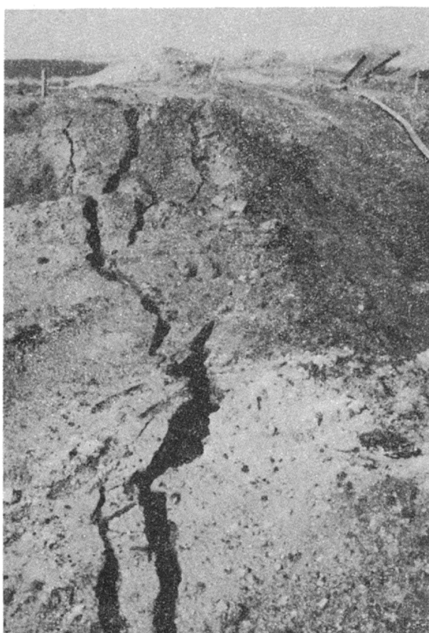
Ryc. 1. Szczeliny i spękania w części wschodniej zwałowiska wewnętrznego (poz. 240).
