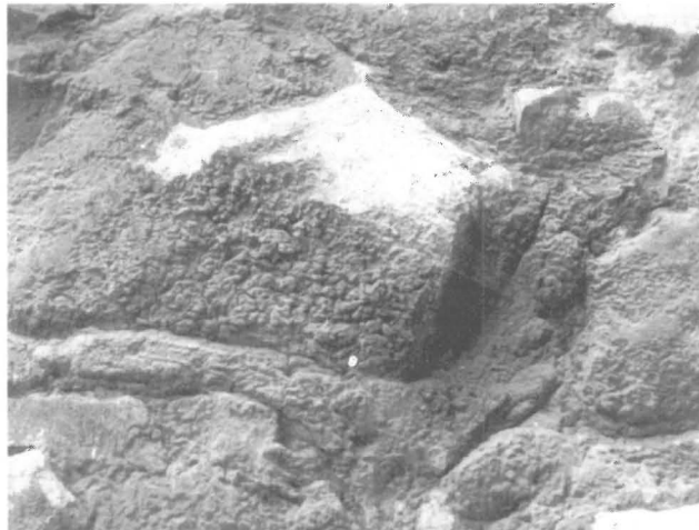
Ryc. 2. Białe i czarne strefy na wapieniu jurajskim. Strefa czarna pokryta naskorupieniem gipsowym o bardzo urozmaiconej morfologii. Brama Floriańska, Kraków (ściana północna)
