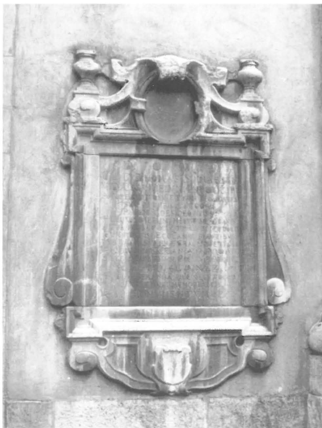
Ryc. 4. Eksfoliacja powierzchniowych warstwek piaskowca glaukonitowego (karpackiego). Budynek Polskiej Akademii Umiejętności i Polskiej Akademii Nauk w Krakowie (fasada od strony ul. św. Marka)
