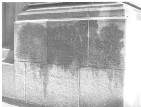
Ryc. 1. Cienka warstewka ciemnego pigmentu na piaskowcu. Collegium Novum, Kraków
