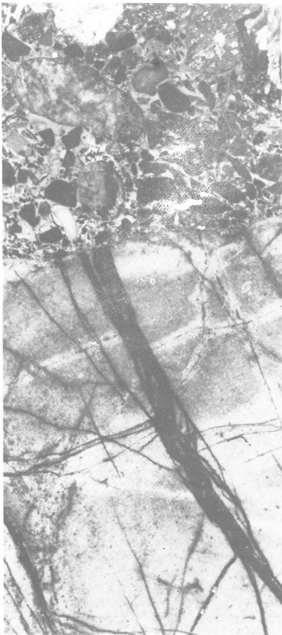
Ryc. 6. Dyskordancja dewon dolny (ems) – trias (wapienie gogolińskie). Na powierzchni erozyjnej hydrotermalnie przeobrażonych kwarcytów (serycytyzacja) i pociętych zwietrzałymi żyłami kruszcowymi kwarcytów leżą zlepieńce klifowe triasu. Zlepieńce zawierają otoczaki okruszczonych kwarcytów i dolomitów dewońskich, a także porfirów zawierających rozsiane kruszce Cu–Mo. W spoiwie zlepieńców sporadycznie występuje młodsza mineralizacja złóż rud Zn–Pb. Zawiercie, otwór RK-3, głębokość 66,0 m, grubość rdzenia 100 mm.
