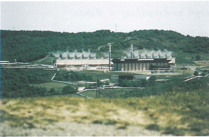
Ryc. 2. Elektrownia geotermalna w okolicach Larderello we Włoszech; wykorzystywana jest tam tylko energia wysokotemperaturowa, ciepło odpadowe ulatnia się w powietrze
