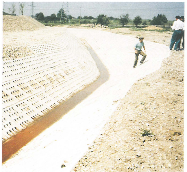
Ryc. 3. Rów opaskowy (próbka 9), odcieki ze stawów z odpadami flotacyjnymi; obie fot. E. Górecka
