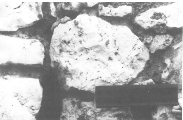
Ryc. 4. Klasyfikacja zniszczeń powierzchniowych wapienia skalistego. Klasa I, grupa 3; skala=20 cm
