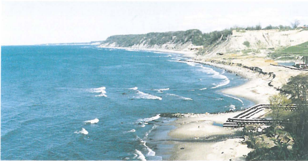
Ryc. 5. Niszczone wybrzeże klifowe Sambii ok. 10 km na zachód od Swietłogorska. Widoczne skutki wielkoskalowej ingerencji w naturalne procesy brzegowe. W założeniu eksperymentu materiał ze stromych zboczy wysoczyzny zepchnięty do morza miał zostać przetransportowany przez prądy przybrzeżne w kierunku wschodnim i zasilić erodowane plaże w Swietłogorsku. Na pierwszym planie widoczna konstrukcja z opon samochodowych mająca blokować transport w kierunku zachodnim. Wyniki eksperymentu nie spełniły oczekiwań; w obszarze na wschód nie zanotowano zwiększonych ilości materiału osadowego, który został najprawdopodobniej wyniesiony w czasie sztormów poza strefę brzegową; fot. S. Uścińowicz
