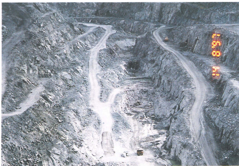
Ryc. 7. Widok odkrywkowej kopalni złoża chromitu w Kemi
