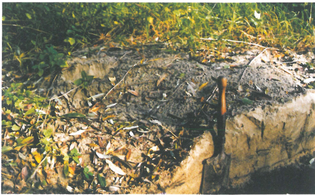
Ryc. 3. Ogólny widok nasypu za wałem przykorytowym Fig. 3. General view of the bar behind a levee
