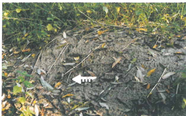
Ryc. 7. Ogólny widok powierzchni nasypu za wałem przykorytowym
