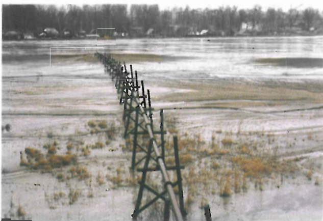
Ryc. 1. Składowisko popiołów z EC „Szczecin” jest już wypełnione. Brak podziału na kwatery, uniemożliwia rotację odpadów i ich ewentualne wykorzystanie. Ryc. 1, 2 fot. W. Irmiński
