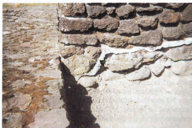
Ryc. 1. Ostrów Lednicki — fragment XI-wiecznej tzw. II budowli z rudy darniowej; fot. J. Skoczylas
