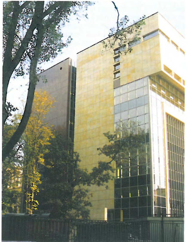
Ryc. 6. Boczna, dwuzielna fasada najnowszego budynku Biblioteki Jagiellońskiej od strony ul. Ingardena, wykonana z czerwonego szwedzkiego granitu Imperial red oraz dolnośląskiego piaskowca z Wartowic. Widoczna również przedwojenna podmurówka ogrodzenia z dolomitu libiąskiego
