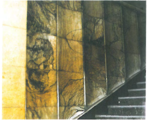
Ryc. 3. Fragment dolnej kondygnacji klatki schodowej najstarszego gmachu Biblioteki Jagiellońskiej. Widoczne schody wykonane z marmuru karraryjskiego z podstopnicami z zelejewskiej „Różanki”. Klatka obudowana wielkimi płytami alabastru z Żurawna z cokoliczkiem z marmuru z Bolechowic. Widoczny także fragment stiukowej ściany westybulu Fig. 3. Fragment of the lower part of the stair-cage in the main building of the Jagiellonian Library. The stairs are made of Carrara marble and front, vertical elements — of Zeleżowa rose marble (Różanka). The walls are covered with huge plates of Żurawno alabaster and the wall base is of Bolechowice marble. Left — fragment of stucco wall of the vestibule
