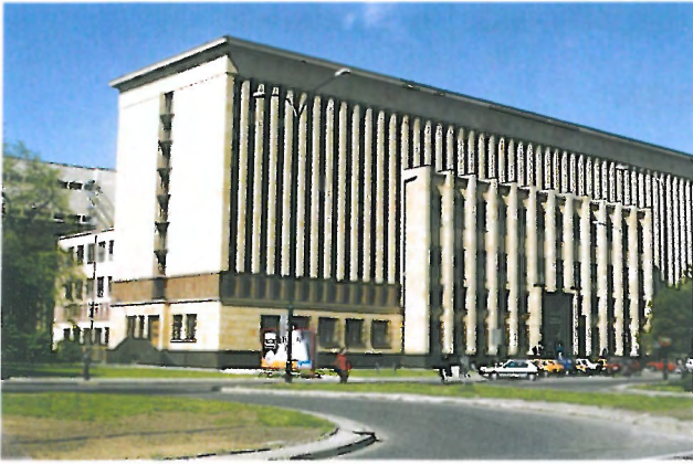
Ryc. 1. Najstarszy gmach Biblioteki Jagiellońskiej przy al. Mickiewicza 24 oblicowany żółto-złocistym piaskowcem dolskim z kamieniołomu w Dołach Biskupich koło Kunowa. W pasie przyziemia, portalu i w obudowie schodów bocznego wejścia widoczny ciemny klesowit, a na wysokości I-go piętra pas różowych granitów. Na drugim planie pozostałe budynki biblioteki Fig. 1. The oldest, main building of the Jagiellonian Library at 24, Mickiewicz street, covered with yellow-goldish sandstone from the quarry in Doły Biskupie near Kunów. Dark klesovite occurs in the ground belt of the building, the portal, and the structure framing the stairs of the side entrance. A belt of rose granite is visible at the first floor level, and the other buildings of the Library in the background
