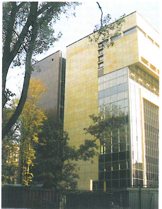
Ryc. 6. Boczna, dwuzdielna fasada najnowszego budynku Biblioteki Jagiellońskiej od strony ul. Ingardena, wykonana z czerwonego szwedzkiego granitu Imperial red oraz dolnośląskiego piaskowca z Wartowic. Widoczna również przedwojenna podmurówka ogrodzenia z dolomitu libiąskiego
