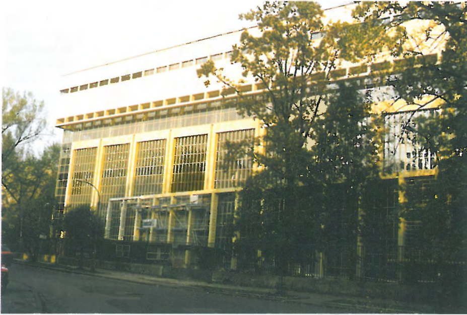
Ryc. 5. Najnowszy budynek Biblioteki Jagiellońskiej od strony ul. Oleandry z fasadą wykonaną z dolnośląskiego piaskowca z Wartowic
