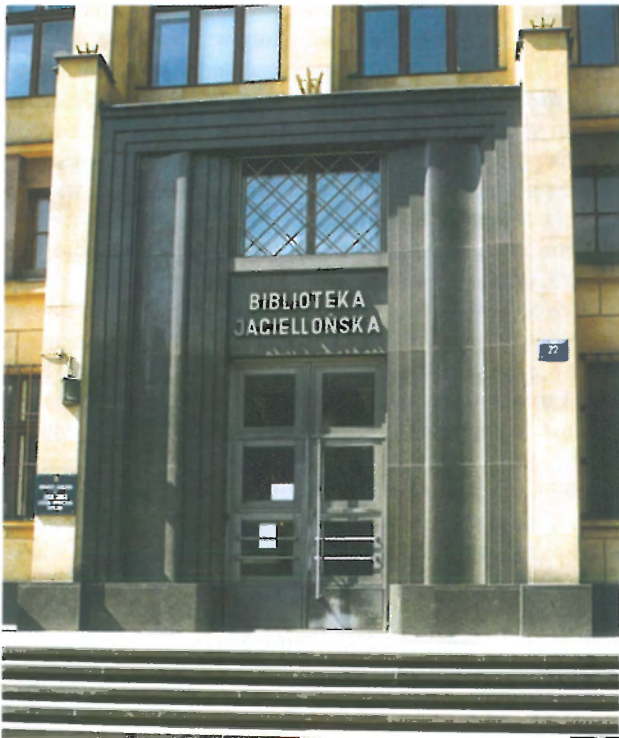
Ryc. 2. Główny portal najstarszego gmachu Biblioteki Jagiellońskiej wykonany z wołyńskiego klesowitu Fig. 2. The main portal of the oldest building of the Jagiellonian Library, made of Volhyn klesovite
