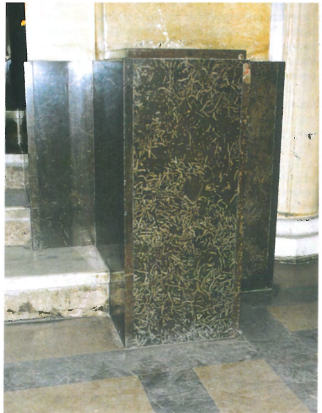
Ryc. 3. Fragment dolnej kondygnacji klatki schodowej najstarszego gmachu Biblioteki Jagiellońskiej. Widoczne schody wykonane z marmuru karraryjskiego z podstopnicami z zelejowskiej „Różanki”. Klatka obudowana wielkimi płytami alabastru z Żurawna z cokoliem z marmuru z Bolechowic. Widoczny także fragment stiukowej ściany westybulu Fig. 3. Fragment of the lower part of the stair-cage in the main building of the Jagiellonian Library. The stairs are made of Carrara marble and front, vertical elements — of Zelejowa rose marble (Różanka). The walls are covered with huge plates of Żurawno alabaster and the wall base is of Bolechowice marble. Left — fragment of stucco wall of the vestibule
