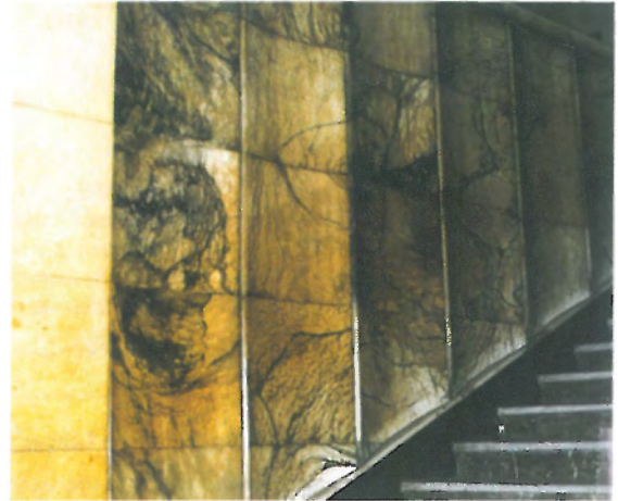
Ryc. 3. Fragment dolnej kondygnacji klatki schodowej najstarszego gmachu Biblioteki Jagiellońskiej. Widoczne schody wykonane z marmuru karraryjskiego z podstopnicami z zelejowskiej „Różanki”. Klatka obudowana wielkimi płytami alabastru z Żurawna z cokoliem z marmuru z Bolechowic. Widoczny także fragment stiukowej ściany westybulu Fig. 3. Fragment of the lower part of the stair-cage in the main building of the Jagiellonian Library. The stairs are made of Carrara marble and front, vertical elements — of Zelejowa rose marble (Różanka). The walls are covered with huge plates of Żurawno alabaster and the wall base is of Bolechowice marble. Left — fragment of stucco wall of the vestibule
