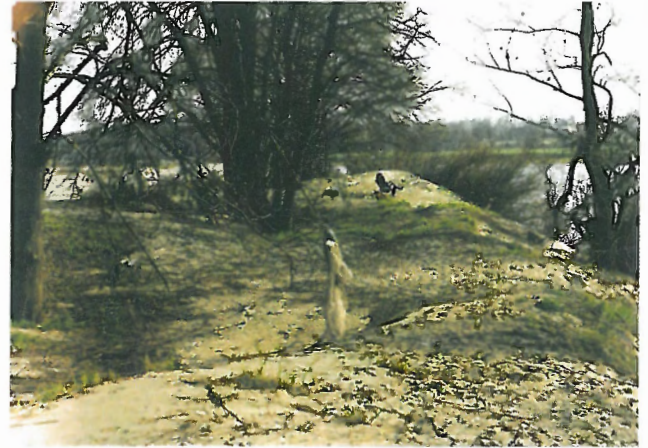
Ryc. 3. Wał brzegowy Odry. Część prawobrzeżna, poniżej ujścia Śleży
