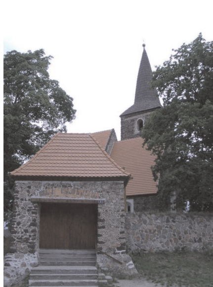
Ryc. 4. XIX-wieczny kościół w Czarnym Lesie w całości zbudowany z ciętych prostopadłościennych bloków rudy darniowej Fig. 4. The 19th-century church at Czarny Las constructed solely of rectangular cut blocks of lump bog iron ores
