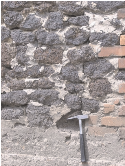
Ryc. 2. Kościół w Studzieniu zbudowany z rud darniowych i głazów narzutowych Fig. 2. The church at Studzieniec built of lump bog iron ores and erratic boulders
