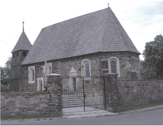
Ryc. 2. Kościół w Studzieniu zbudowany z rud darniowych i głazów narzutowych Fig. 2. The church at Studzieniec built of lump bog iron ores and erratic boulders
