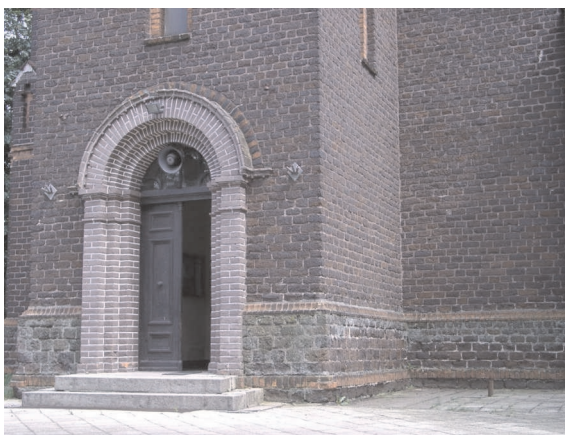
Ryc. 4. XIX-wieczny kościół w Czarnym Lesie w całości zbudowany z ciętych prostopadłościennych bloków rudy darniowej Fig. 4. The 19th-century church at Czarny Las constructed solely of rectangular cut blocks of lump bog iron ores
