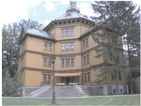
Ryc. 5. Pałac w Antoninie z podmurówką wykonaną z rudy darniowej Fig. 5. The mansion at Antonin with underpinning stone work made of lump bog iron ores
