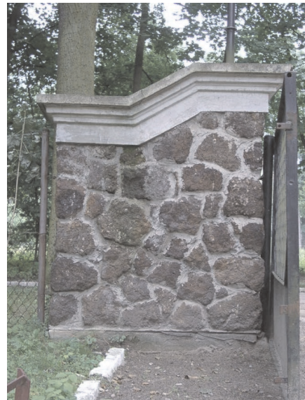
Ryc. 5. Pałac w Antoninie z podmurówką wykonaną z rudy darniowej Fig. 5. The mansion at Antonin with underpinning stone work made of lump bog iron ores
