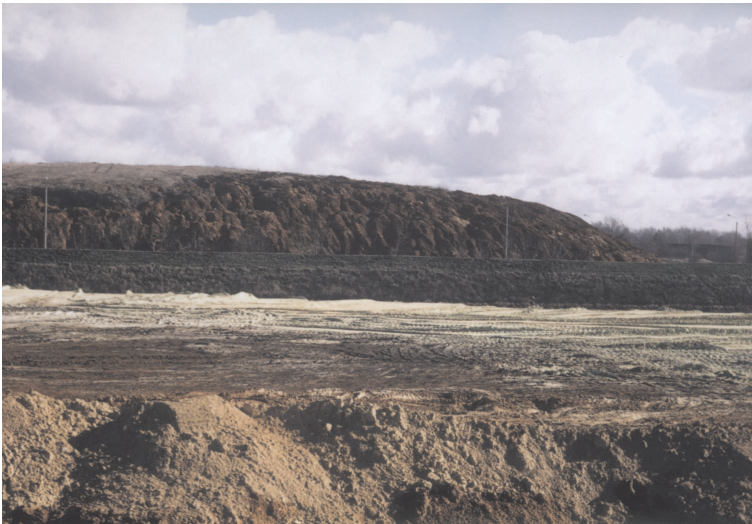
Ryc. 2. Składowisko fosfogipsów Zakładów Chemicznych Police S.A.
