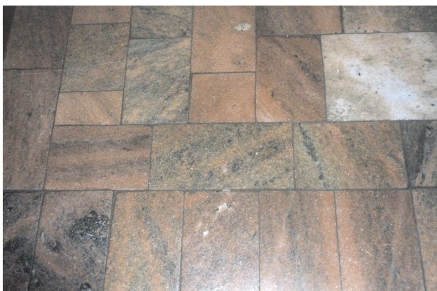
Ryc. 7. Okładzina z polerowanych płyt różowej Sliudianki w budynku krajowego portu lotniczego w Irkucku
