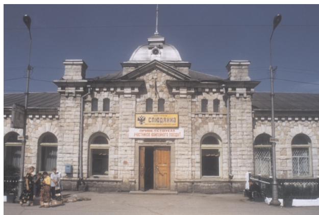
Ryc. 6. Elewacja budynku dworca kolejowego w Sliudiance
