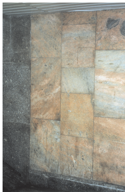
Ryc. 9. Ściana podziemnego przejścia pod alejami Krasińskiego, nieopodal mostu Dębnickiego w Krakowie, wyłożona płytami różowej Sliudianki
