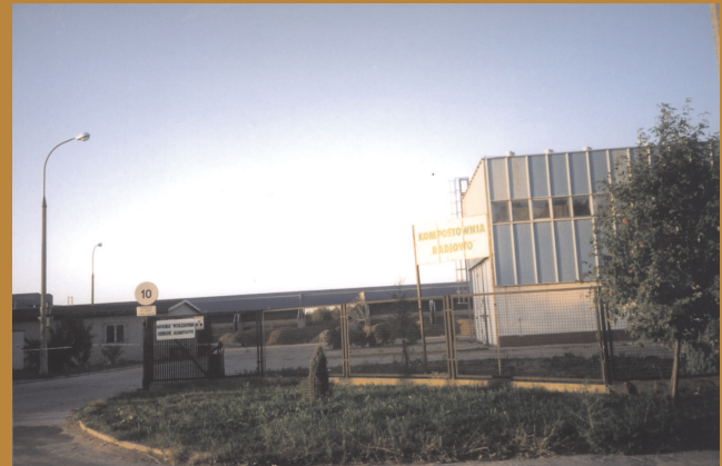
Ryc. 4. Największa w Polsce kompostownia odpadów komunalnych w Radiowie (rejon NW Warszawy) — jeden z nielicznych przykładów przyjaznego dla środowiska sposobu postępowania z odpadami. Fot. A. Dragowski
