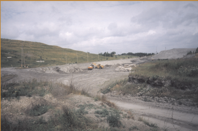
Ryc. 3. Składowisko popiołów Elektrociepłowni Stekierki w Zawadach (gm. Warszawa-Wilanów); po prawej, w głębi, widoczna część czynna składowiska, po lewej nieczynna, zrehabilitowana z ukształtowanymi, zadamonionymi zboczami. Fot. A. Srokowska-Okońska
