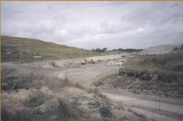
Ryc. 3. Składowisko popiołów Elektrociepłowni Stekierki w Zawadach (gm. Warszawa-Wilanów); po prawej, w głębi, widoczna część czynna składowiska, po lewej nieczynna, zrehabilitowana z ukształtowanymi, zadamonionymi zboczami. Fot. A. Srokowska-Okońska
