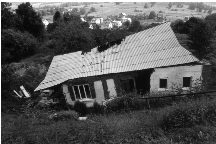
Ryc. 12. Zniszczony dom na krawędzi wtórnej osuwiska
