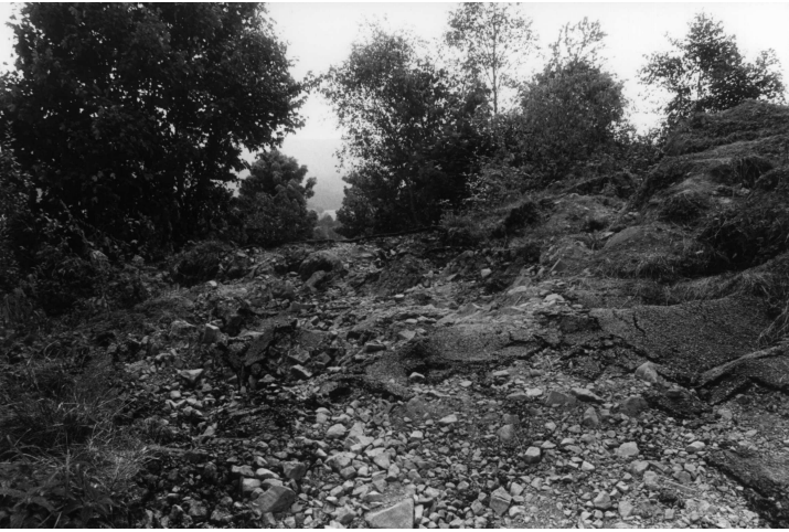
Ryc. 8. Stara droga asfaltowa, przecięta północno-wschodnią niszą boczną Fig. 8. Old road at Lachowice landslide area, broken by the NE landslide niche
