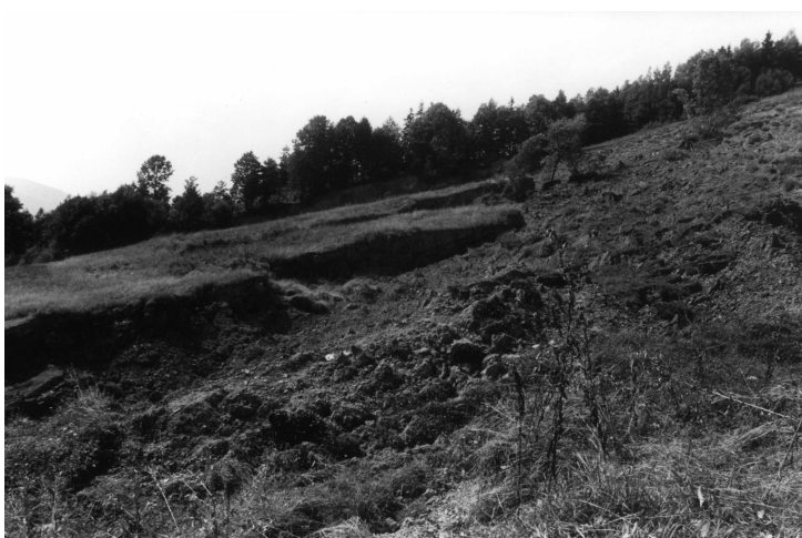
Ryc. 7. Widok na powierzchnię poślizgu i górną część płata osuwiskowego Fig. 7. View of the landslide slip surface and the upper part of the landslide colluvium
