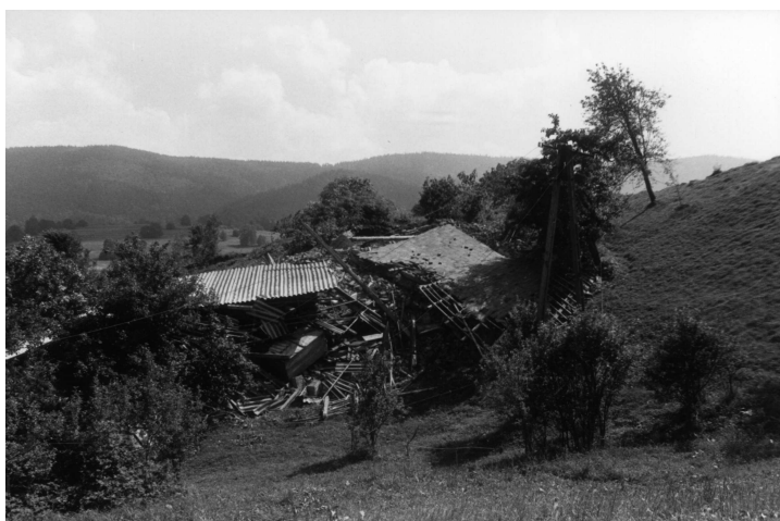
Ryc. 11. Kompletnie zniszczony dom, przy krawędzi wtórnej niszy i dolnej części płata osuwiskowego
