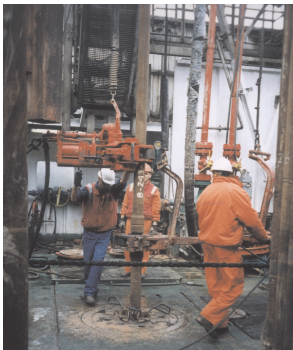
Ryc. 2. Wyciąganie przewodu wiertniczego
