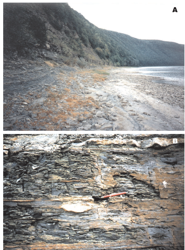
Ryc. 3. Spękany maszyn skalny w przełomie Dniestru koło Zaleszczyk; A — widok ogólny, B — spękania w łupkach sylurskich
