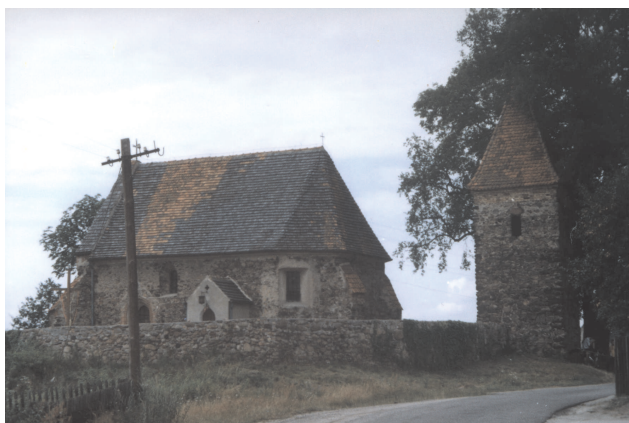
Ryc. 1. Lutynka. Kościół gotycki z XIII w., przebudowany w XV w., zbudowany z głazów narzutowych i rudy darniowej (fot. 1–4 D. Kuchmistrz)
