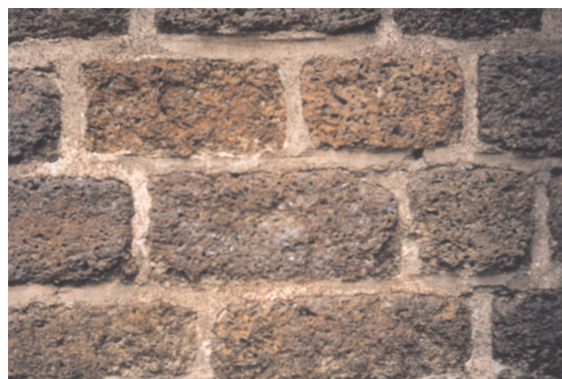
Ryc. 6. Czarny Las. Sposób ułożenia i uformowania rudy darniowej
