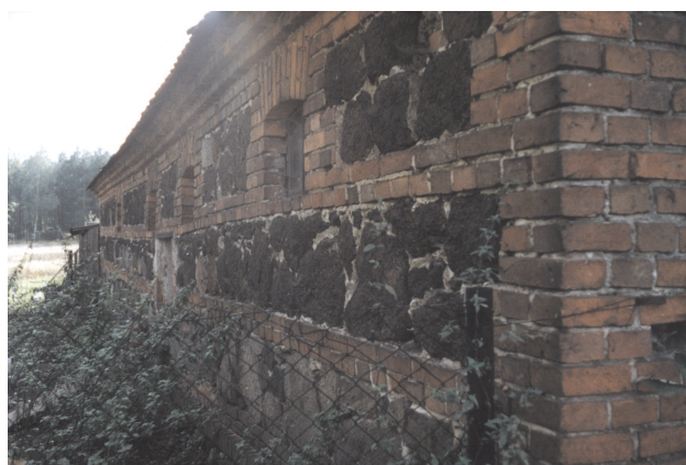
Ryc. 4. Zatonie. Mur z cegły i rudy darniowej z XIX w. otaczający ruiny kościoła
