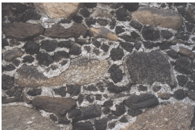
Ryc. 2. Lutynka. Ozdobny? sposób ułożenia darniowej rudy żelaza w ścianie kościoła
