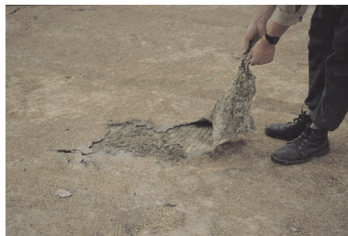
Ryc. 10. Szczeliny z wysychania na dnie stawu pokrytego matą zbudowaną z materiału, głównie mineralnego Fig. 10. Mud-cracks in the bottom of infiltration pond; the bottom is covered by mat consisting mostly of mineral material
