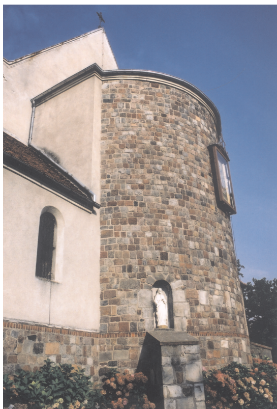
Ryc. 3. Absyda kościoła w Kotłowie Fig. 3. Church's apse in Kotłów
