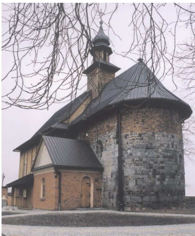
Ryc. 1. Kościół w Kościelecu Kaliskim zbudowany z kostki piaskowcowej Fig. 1. Church in Kościelec Kaliski built with sandston
