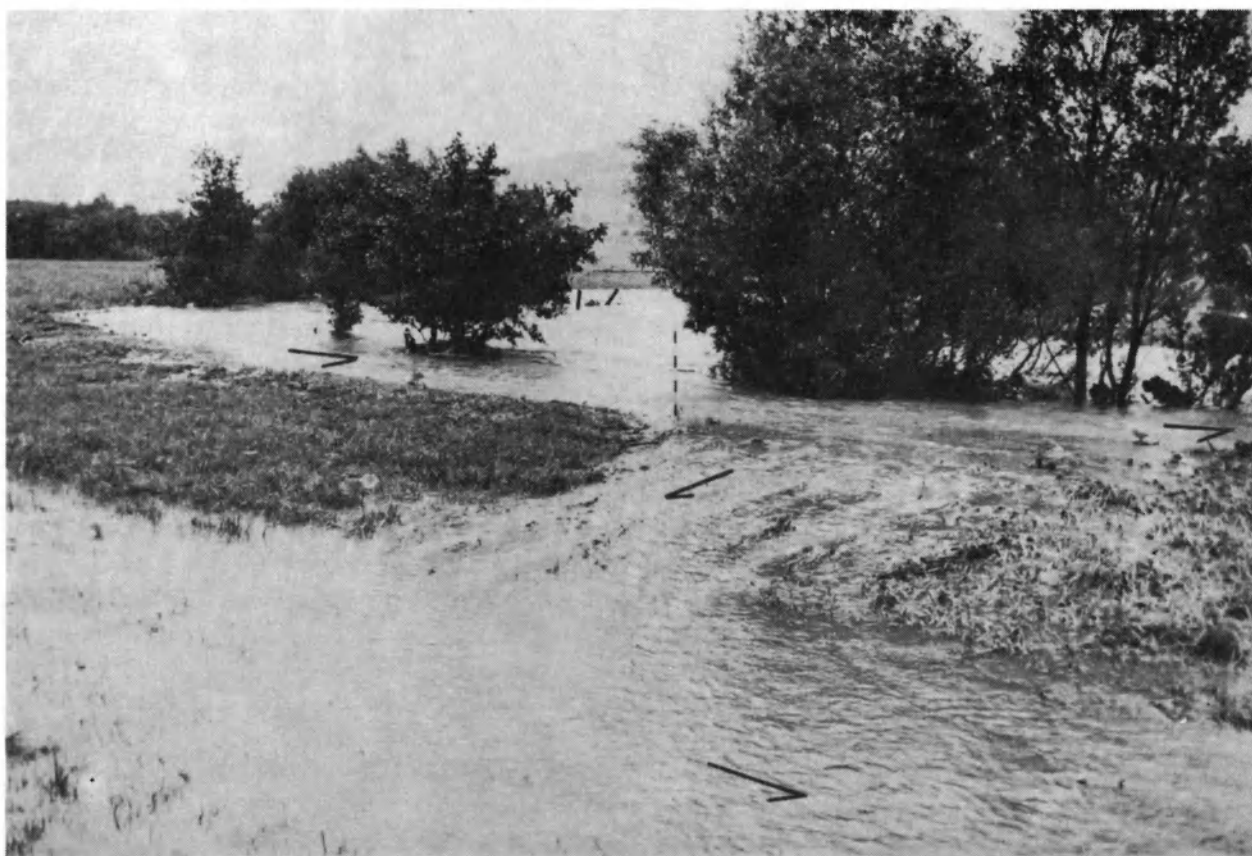
Fig. 7. Przepływ zbliżony do krytycznego w miejscu przelewania się wód powodziowych nad grzbietem wału brzegowego do koryta krewasowego (na pierwszym planie). W korycie rzeki i w korycie krewasowym przepływ był spokojny. Bóbr, odcinek badawczy w Bukowce, 2 sierpnia 1977 r. Stan rosnący
