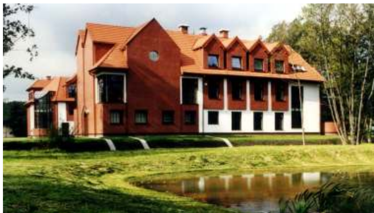
Nowa, od 1998 r., siedziba Oddziału Geologii Morza w Gdańsku-Oliwie, widok wschodniej elewacji od strony stawu
