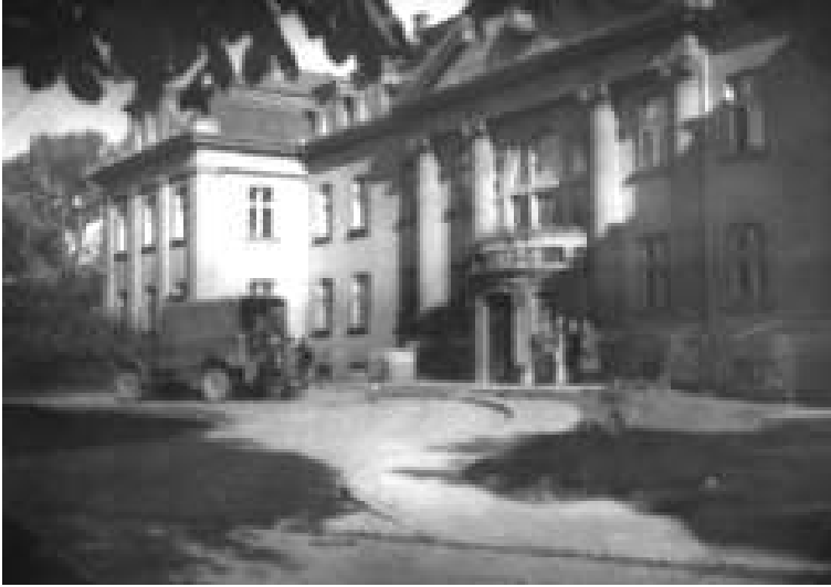
Budynek w Czeladzi, w którym mieściła się Stacja Górnośląska w latach 1945–1960, własność kopalni „Saturn”
