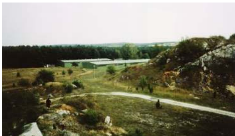
Archiwum Rdzeni Wiertniczych w Kielnikach – stan obecny, widok od strony starego kamieniołomu
