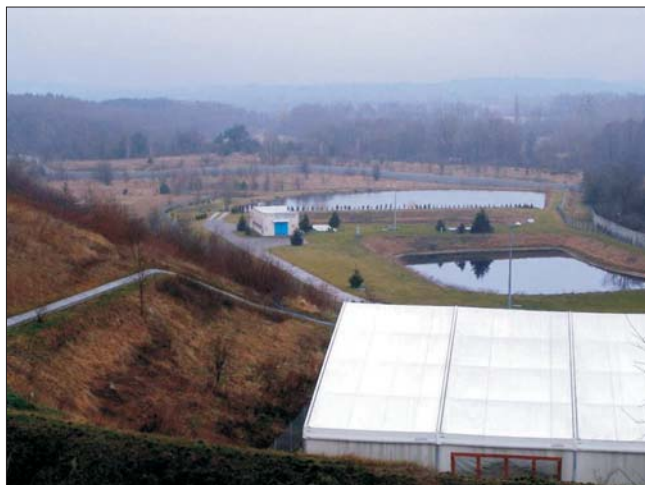
Fig. 16. Zbiorniki odcieków oczyszczonych i nieoczyszczonych na składowisku
