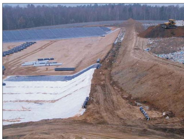
Fig. 32. Kwatery składowiska Suchy Las: nowo budowana i obecnie eksploatowana
