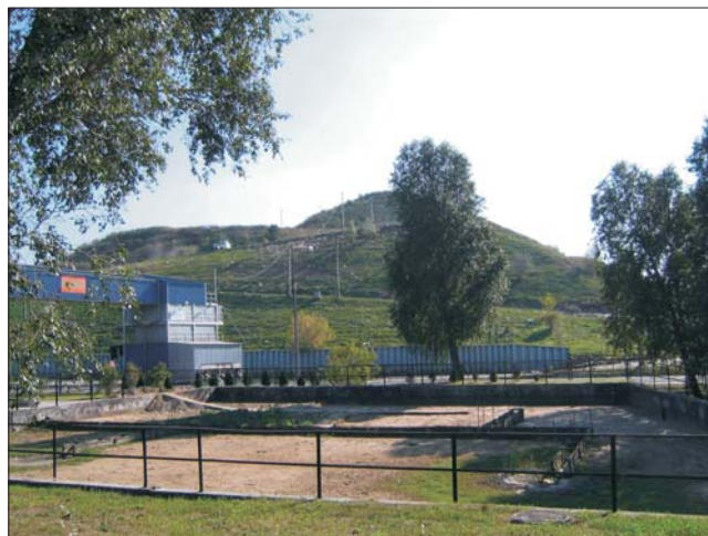
Fig. 4. Składowisko odpadów komunalnych (obecnie odpadów balastowych) w Radiowie k. Warszawy
