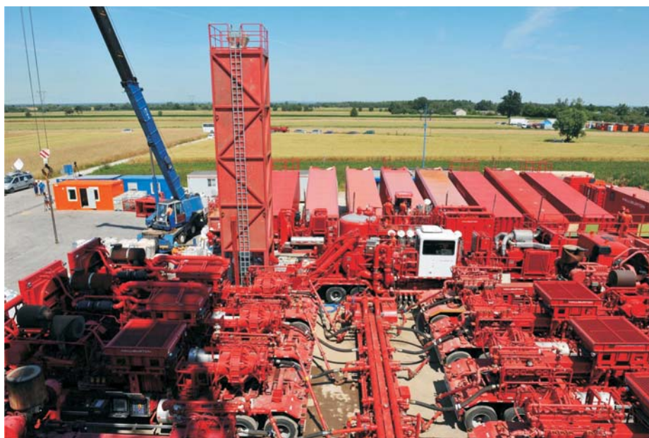
Fig. 4. Przykładowy teren prac w trakcie szczelinowania hydraulicznego (Markowola, powiat zwoleński), źródło: Archiwum PGNiG SA
