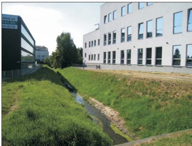
Fig. 3. Widok rowu przed zalaniem budynku. Fot. K. Traczyński
