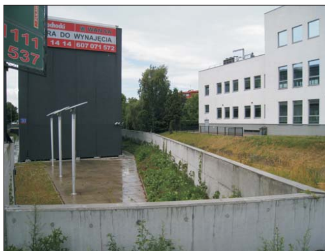
Fig. 6. Biurowiec zabezpieczono dodatkowo groblą i żelbetowym murem. Fot. K. Traczyński
